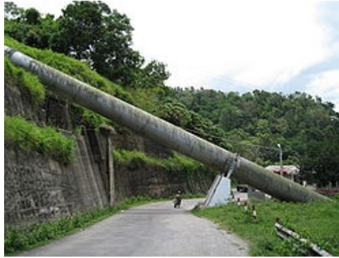
Hai ống thủy áp bằng hợp kim của nhà máy thủy điện Đa Nhim Đà Lạt (hình Wikipedia)
